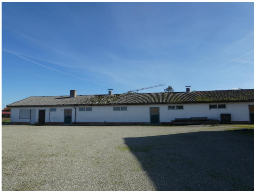
Foto 3: Ehemalige Kälbererei auf Flst. 4825 (Foto vom 25.10.2022).
