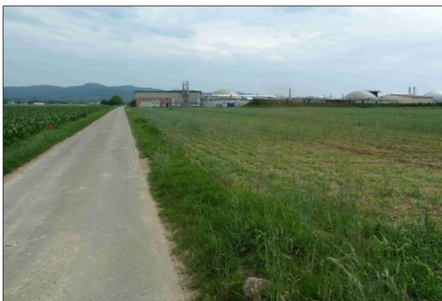
Foto 2: Bauabschnitt 2 vor der Erweiterung der Biogasanlage im Jahr 2013, Blickrichtung Südwest (Nov. 2012).
